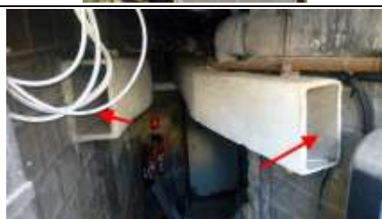
Photo n° Ph006 Localisation : salle C -1-1 sous sol; salle C -1-2 sous sol Ouvrage : 6 - Conduits et accessoires intérieurs - Conduits de fluides (air, eau, vapeur, fumée, échappement, autres fluides) Partie d'ouvrage : Conduit en fibres-ciment Description : Conduit en fibres-ciment Localisation sur croquis : M006
